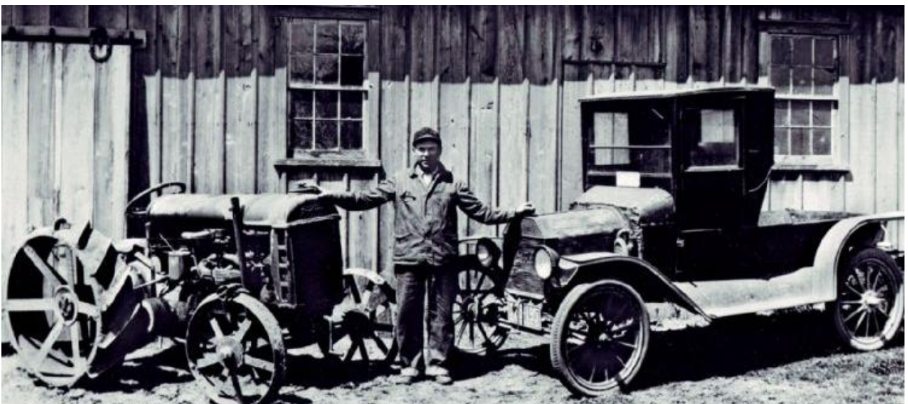
Prototipo del trattore FORDSON F (1917) che Henry ha derivato dalla FORD T tutto dopo molte ed accurate sperimentazioni avendo ideato un nuovo corpo , solidale col motore e contenente la frizione
